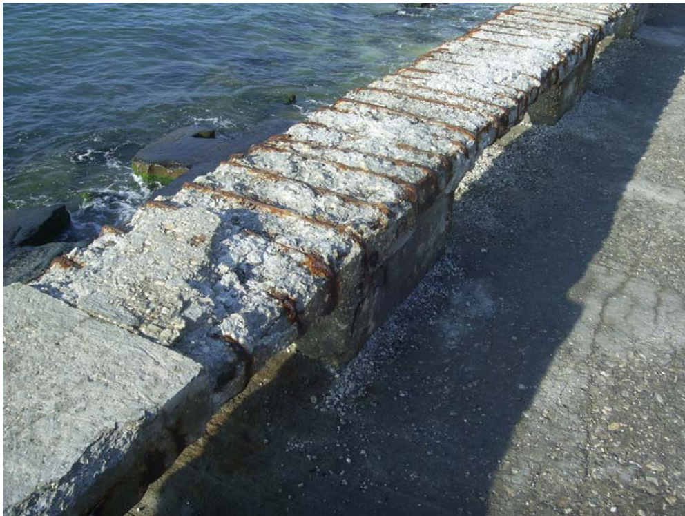
Фото 3. Състояние на ст/бетонния парапет на дамбата
